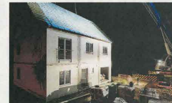
En une journée, entre 8 h et 18 h 30, la société Modulart monte une maison avec des modules préfabriqués en usine.
