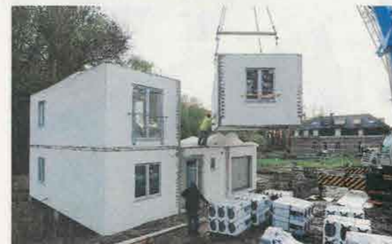
En une journée, entre 8 h et 18 h 30, la société Modulart monte une maison avec des modules préfabriqués en usine.
